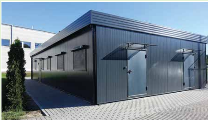
Nowe zaplecze sanitarno-szatniowe przy Szkole Podstawowej w Grodźcu
